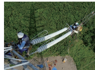
275kV架線工事における緊線作業
