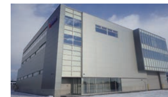
日昭アルミ工業株式会社札幌社屋電気設備工事
