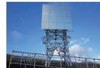
山岳部への電波反射板新設工事
