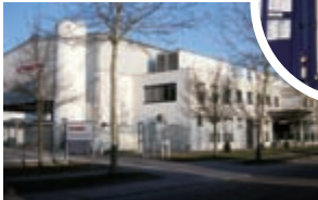
ドイツにある同社グループの工場と熱処理設備 (窒化炉)
