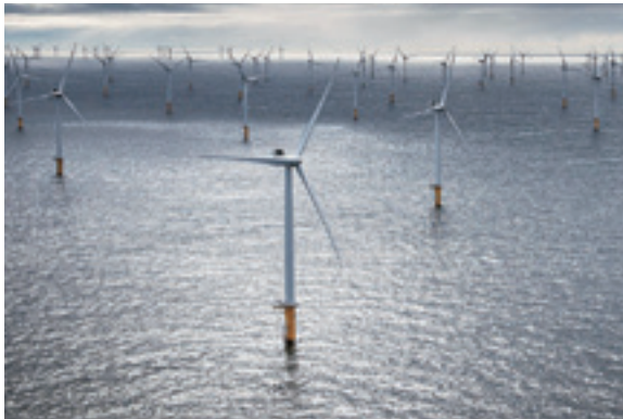
洋上風力発電設備
