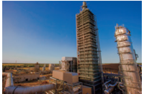
石炭焚き火力発電設備向けCO 2 回収プラント
