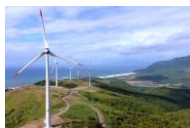
尻別風力発電所建設工事
