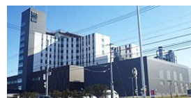
帯広厚生病院エネルギー等 電機・機械設備工事
