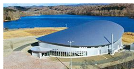
国立民族共生公園体験交流ホール 電気設備工事
