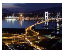
白鳥大橋屋外電気設備 工事
