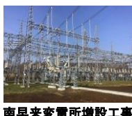
南早来変電所増設工事
