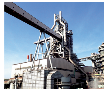
和歌山製鐵所新第2高炉
