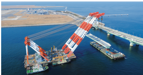
復旧工事の様子
