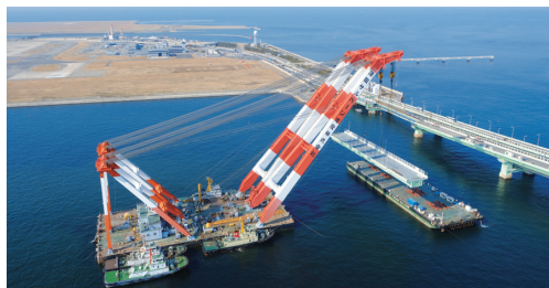
復旧工事の様子
