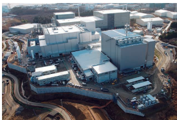
福島県双葉町減容化施設
