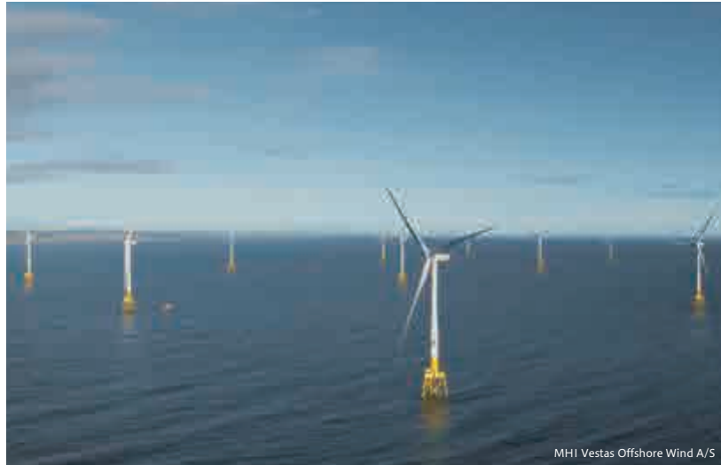
洋上風力発電設備
