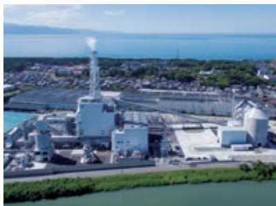
鈴川エネルギーセンター株式会社殿 鈴川エネルギーセンター火力発電所 外観
