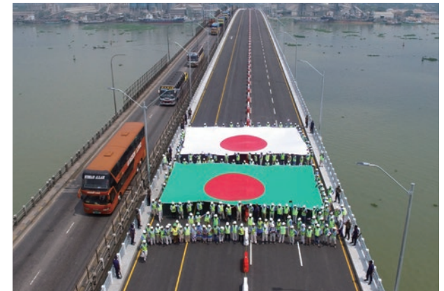
メグナ新橋完成時（左側が既存橋、右側が新橋）
