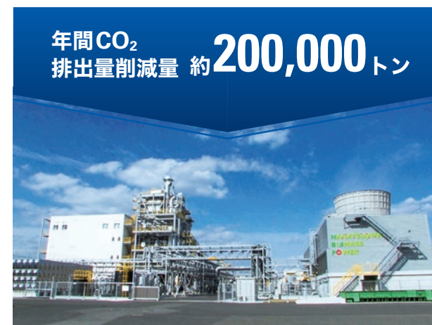
七ツ島バイオマス発電所
