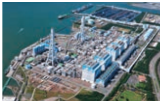
アンモニア混焼の実証事業を行なう株式会社JERAの碧南火力発電所 (提供写真：株式会社JERA)
