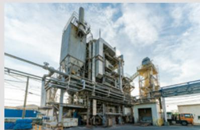
群馬第1工場には、茶粕・コーヒー粕・廃水処理汚泥を「燃料」として再利用する焼却ボイラーを設置しています。ボイラーで焼却した茶粕・コーヒー粕は肥料や建築用原料として利用されています。なお、ボイラーは廃棄物の減量だけでなく、工場内の省エネルギーにも役立っています。
