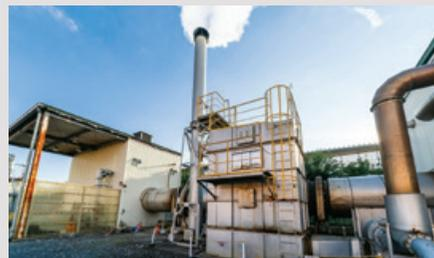
利根川工場の敷地内には、含水率70~90%の茶粕・コーヒー粕を含水率10%以下まで乾燥させるロータリーキルン式の乾燥機が設置されています。この装置で乾燥した茶粕・コーヒー粕は牧場の牛舎・豚舎の敷床として再利用されており、専門業者に売却しています。廃棄物のリユースだけでなく、費用削減にも効果を発揮しています。
