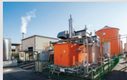
利根川工場にあるバイオガス発電設備は、茶粕・コーヒー粕に加え、工場内の廃水処理設備から排出される汚泥を発酵処理し、生成されたバイオガス(メタンガス)で発電を行うエネルギープラントです。発電した電力の全てが、電力供給会社を通じて群馬県の地元施設に供給されています。
