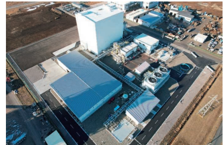
苫小牧市のバイオマス発電所
