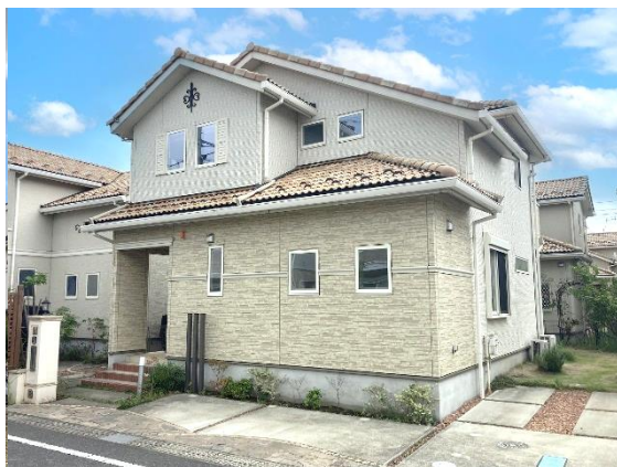
【既存外壁材】 【窯業系サイディング】
