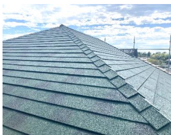
【屋根カバー工事】
