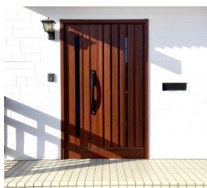
【玄関ドア交換】
