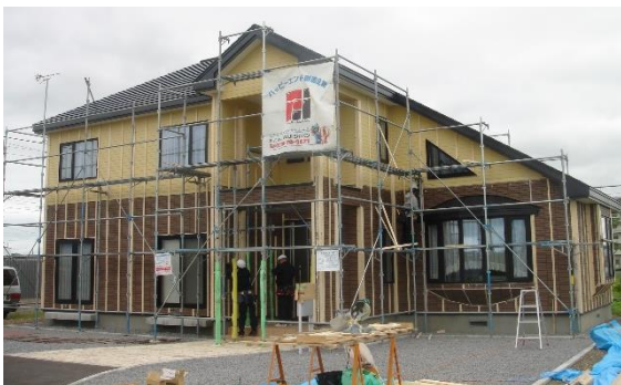
【施工現場全景】
