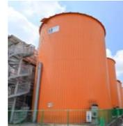
飲料製造工程で排出される生産粕（コーヒー粕・穀物茶粕）や脱水污泥等を利用し、再生可能エネルギーであるバイオガスを生成。バイオガスは発電、発酵タンク加温に使用する温水に再利用されます。
